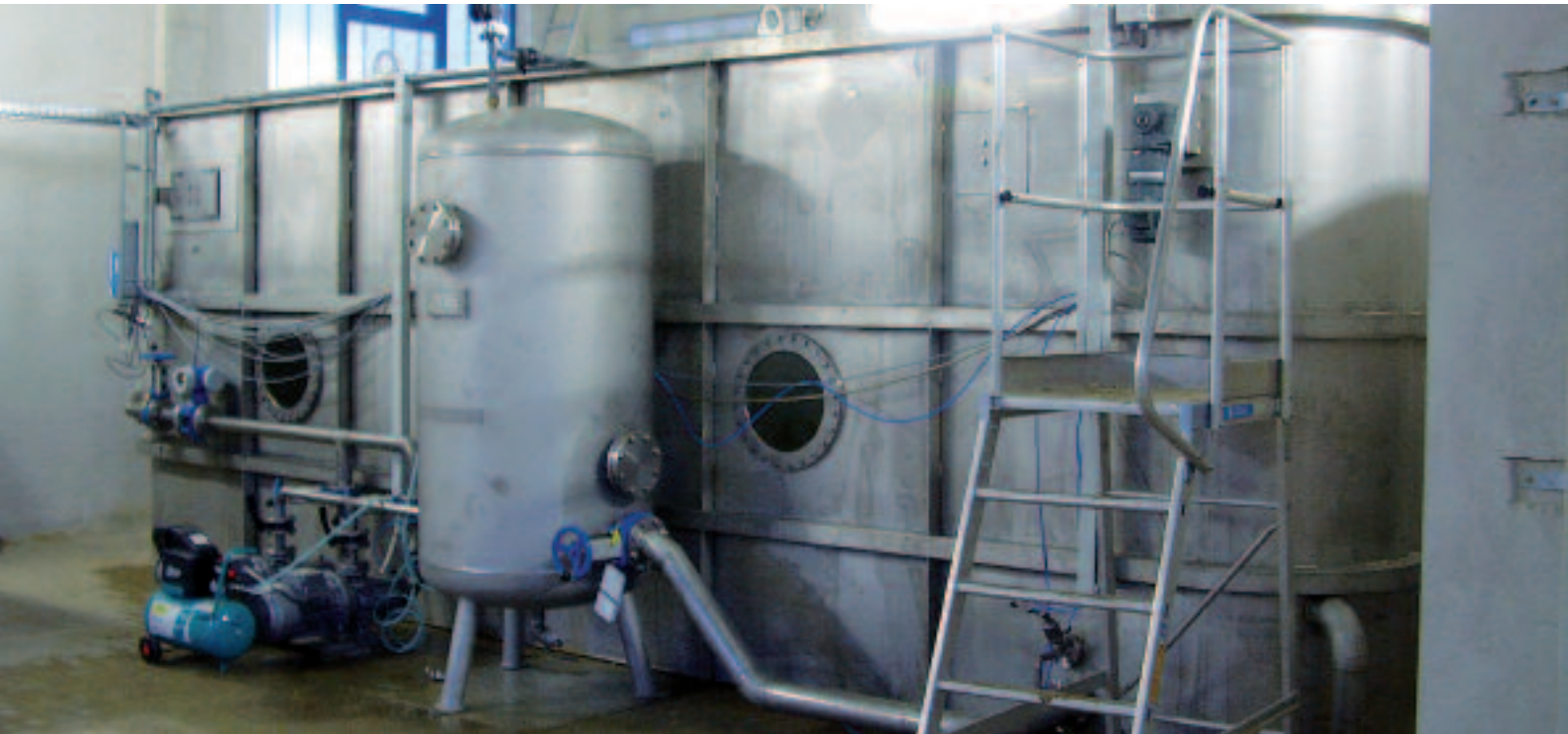
Flotationsanlage mit Druckwasserkessel
