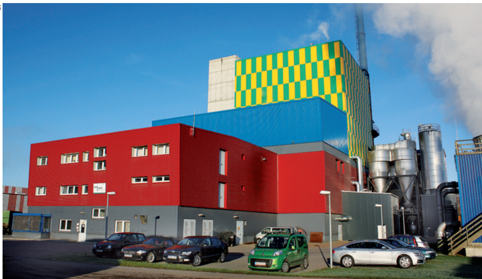
Biomasse Heizkraftwerk in Herbrechtingen, Baden-Württemberg
