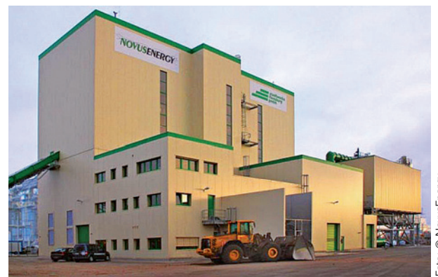
Biomasse-Heizkraftwerk in Brunsbüttel, Schleswig-Holstein
